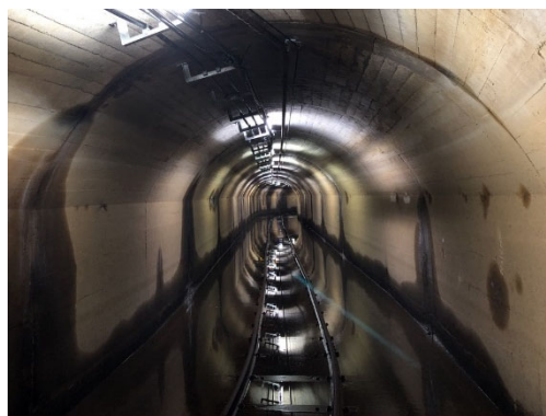
図-1 既設取水トンネル
