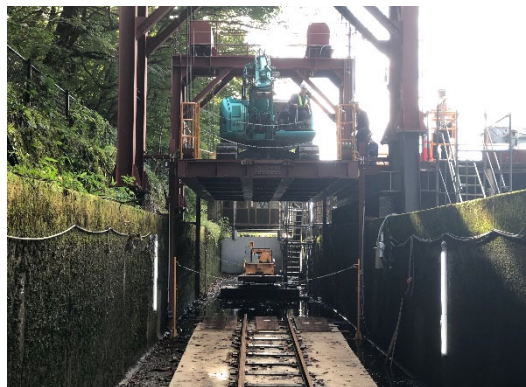
図-4 昇降架台設備
